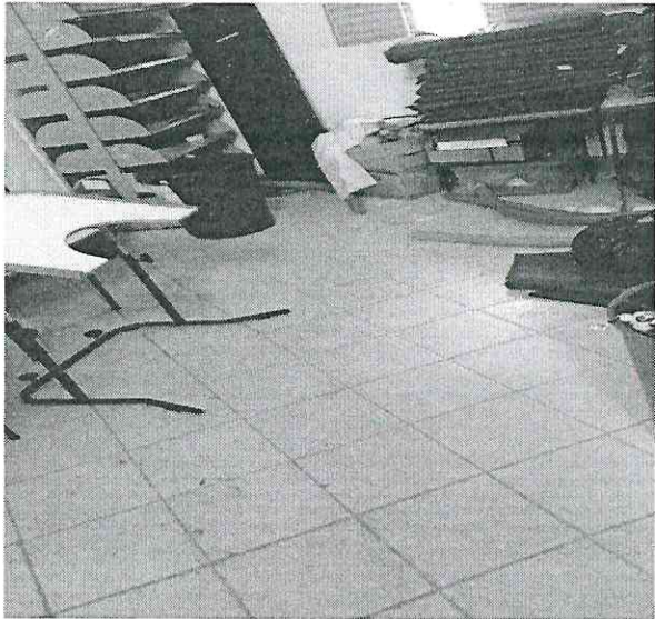
1. Vista da sala onde serão construídos os banheiros.
